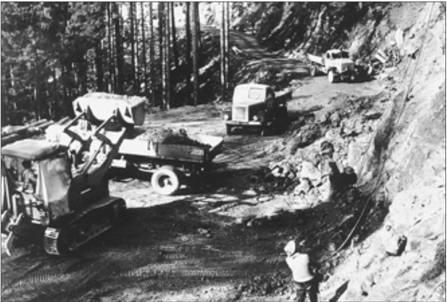
Der fertige Kies wird auf Lastwagen geladen, auf der Fahrbahn verteilt und nochmal abgewalzt.
